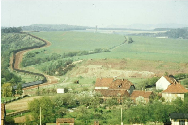
Abb. 21: Wohl in den 1970er/80er Jahren entstandene Aufnahme der Grenze im Südharz (Ortschaft Zwinge), etwa 10 km südwestlich von Ellrich
