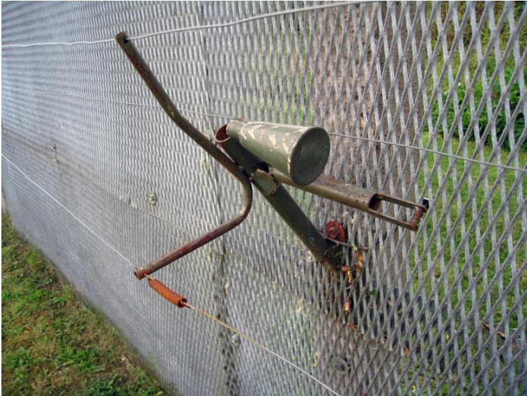
Abb. 2: Rekonstruktion einer Selbstschussanlage SM 70 am Grenzzaun bei Schlagsdorf (Ratzeburger See). Der Streckmetallzaun war so konstruiert, dass Flüchtende nicht mit den Fingern zwischen die scharfkantig-engen Maschen fassen konnten. Die Verschraubung der Zäune war nur „feindwärts“, von Westen aus, zu lösen, 2009
