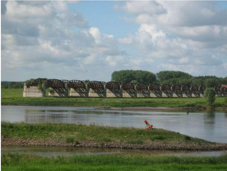
Abb. 11: Die im Zweiten Weltkrieg teilzerstörte Eisenbahnbrücke bei Dömitz an der Elbe wurde, da sie die innerdeutsche Grenze querte, nach 1945 nicht wiedererrichtet und erlitt DDR-seits weitere Abrissmaßnahmen, 2010
