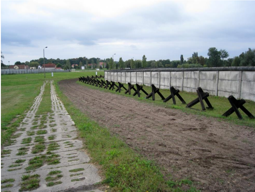
Abb. 18: Aufbau der Grenzanlagen bei Hötenleben mit Signalzaun (links), Kolonnenweg und gepflügtem Kontrollstreifen (Mitte) sowie Grenzmauer mit vorgesetzten Fahrzeugsperrern (rechts), 2009
