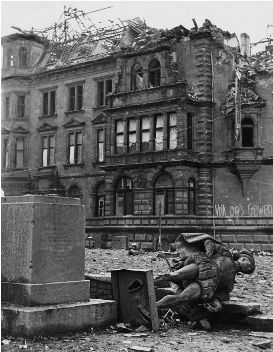
Die kriegsbeschädigte Innenstadt von Wiesbaden.
