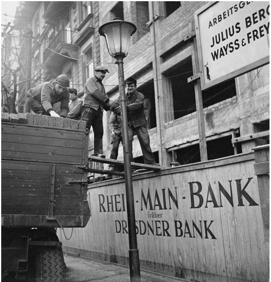
Bau des Bürohauses der Rhein-Main-Bank, Gallusanlage 7, 1951.
